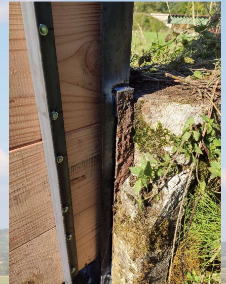
Neue Schützentafeln und Reparatur der Führungsschienen „Neuwiesen“
