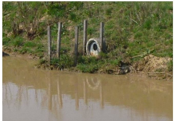
Protection d'une canalisation
